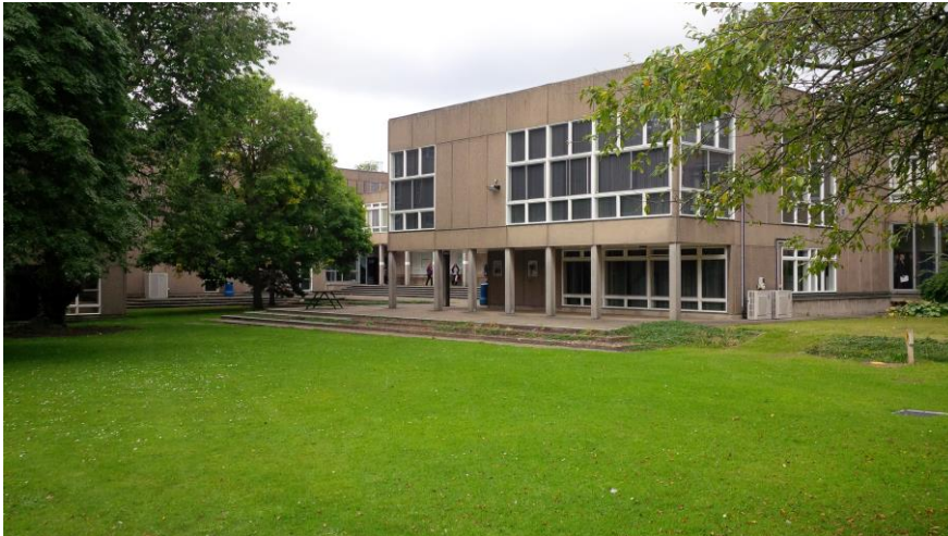
Zentraler Bereich des Derwent College
